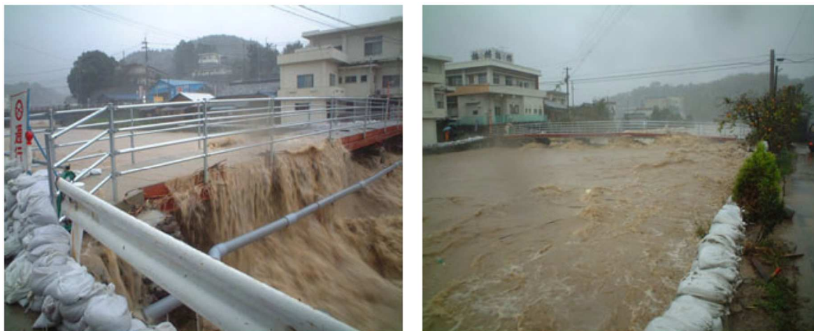
図 3 洪水時の状況写真(平成 16 年 10 月台風 23 号 : 5k200 付近)
