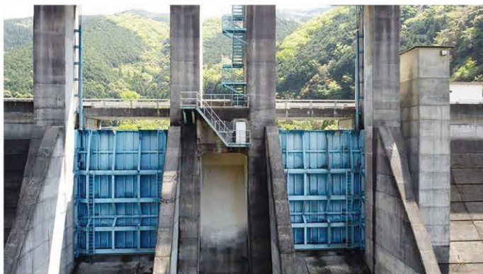
ゲートローラ改良工事（山財ダム）
