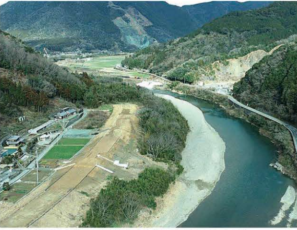
堤防の整備（肱川激甚災害対策特別緊急事業）
