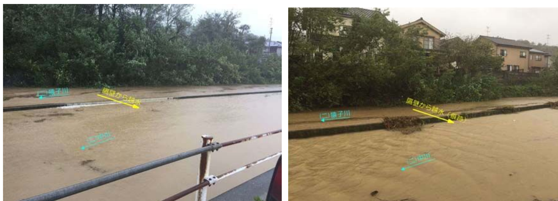
写真 1.3. 平成 30 年(2018 年)台風第 24 号 出水時状況写真 (今治市提供) 「コンクリート背割堤(猿子川)からの中川への越水のみ」
