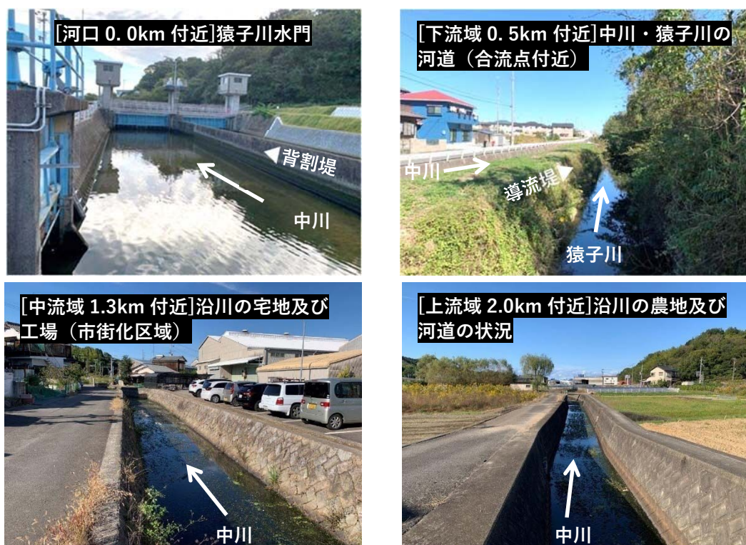
写真 1.1. 中川 現況写真
