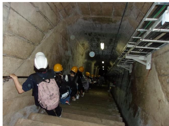
ダムの中（監査廊）を移動中
