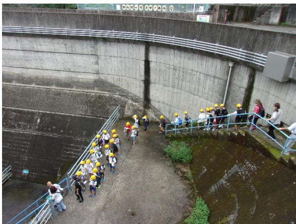
監査廊に移動中
