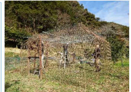
設置作業中のサル大型捕獲檻
