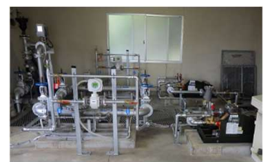
かんがい施設更新状況
