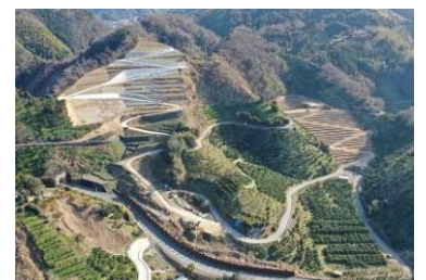
再編復旧工事中
