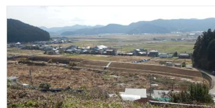
ため池改修状況
