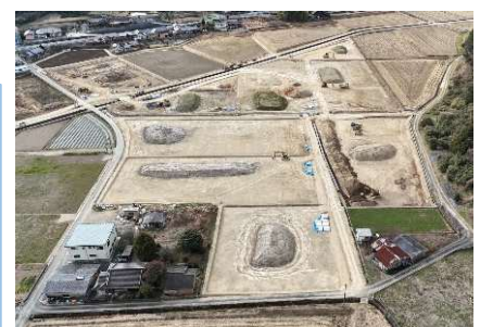
ほ場整備施工状況（伊延西）
