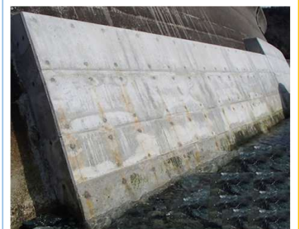
護岸補修状況
