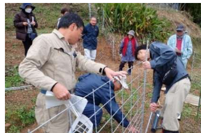
地域ぐるみの防護柵設置
