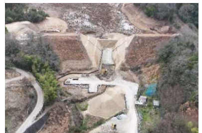
【図17】農業用ため池の老朽化対策施工状況（三秋大池地区）
