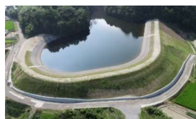
【図28】農業用ため池の老朽化対策施工状況（下林岡池）
