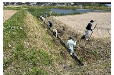
共同活動（水路の泥上げ）
