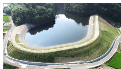
ため池の改修
