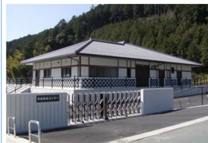
農業集落排水施設
