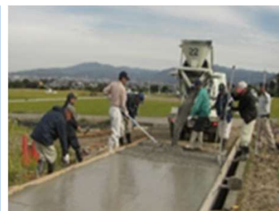
農道の簡易舗装
