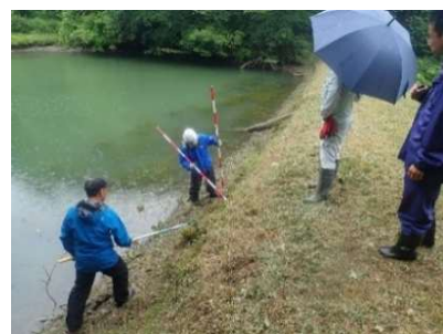
ため池の点検調査
