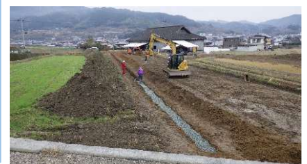
暗渠排水施工状況（野村）
