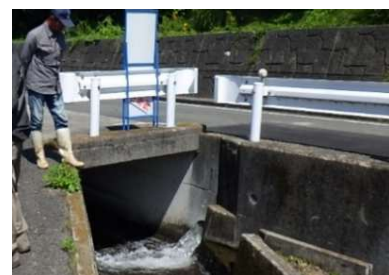
【図27】基幹水利施設の通水確認状況（佐古地区）
