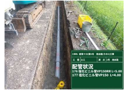
〔図11〕用水路のパイプライン化管路施工状況（ナベラ地区）
