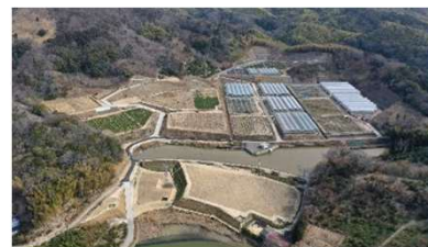
【図26】樹園地再編整備の施工状況（下難波地区）
