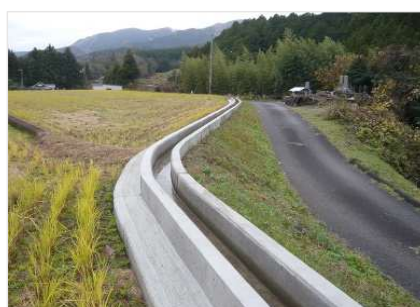
農業用排水路
