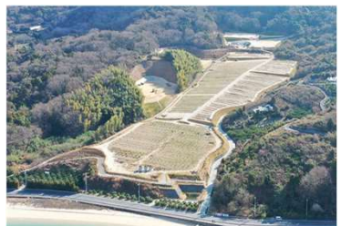
樹園地の再編復旧 （上浦地区盛工区）
