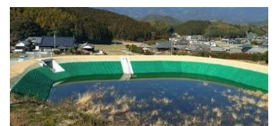
ため池改修工事（中池）
