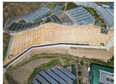
【図18】樹園地再編整備の施工状況（砥部地区）
