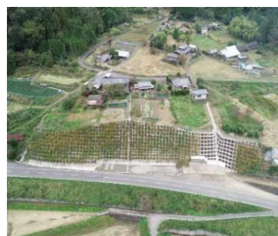
地すべり対策（斜面崩壊防止）
