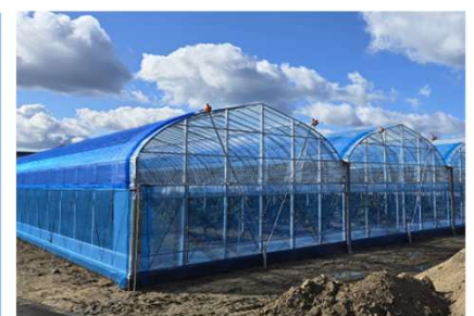
中古資材を活用したハウスの整備
