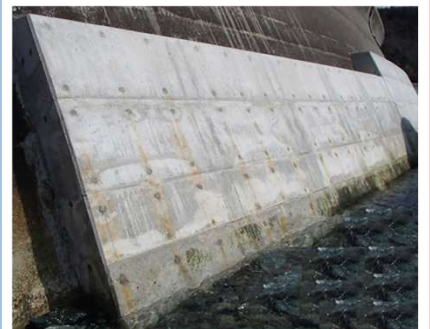
護岸補修状況
