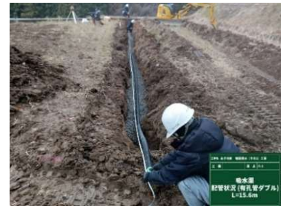
〔図12〕暗渠排水の設置状況（永子地区）
