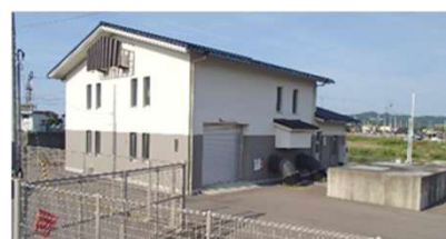
排水機場の整備
