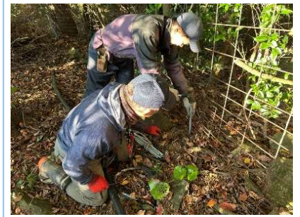
獣害対策のための 防護柵設置
