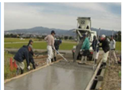
農道の簡易舗装
