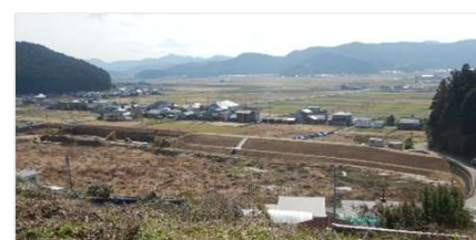
ため池改修状況
