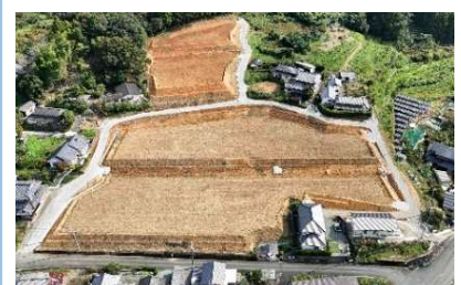
区画整理施工状況
