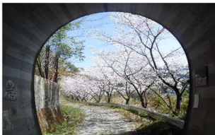
【梨ノ木谷隧道】
