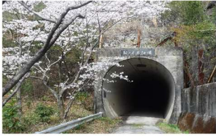
【梨ノ木谷隧道】
