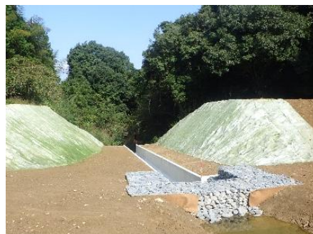
廃止後（堤体の開削） （宇和島市：瀬戸地区）
