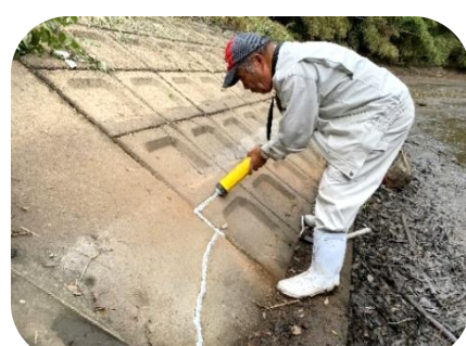
ため池の補修 (東温市)
