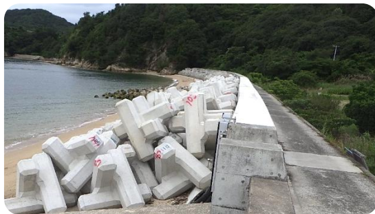
堤防の嵩上げ（上島町：佐島東地区）
