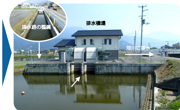
排水機場の整備（西条市：玉津・下島山地区）
