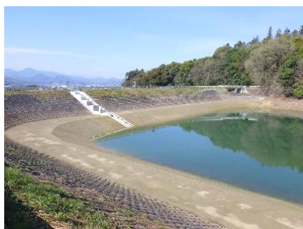
耐震対策後(押え盛土の追加) （東温市：追入下池地区）
