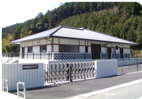
農業集落排水施設の整備
