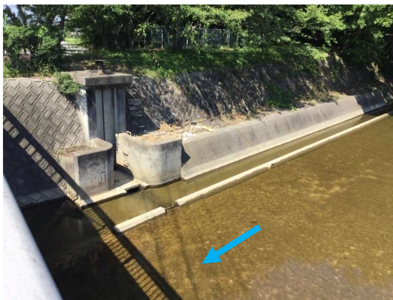
写真 5. 取水堰（釜の口堰）
