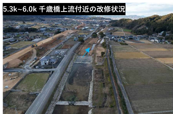
写真3. 河川の整備状況（高水敷整備）
