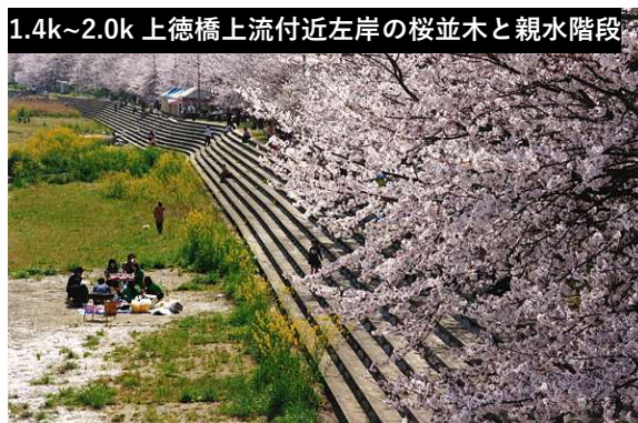
写真4. 河川の整備状況（階段護岸）
