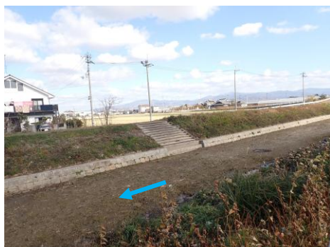
図 8 大谷川の親水護岸（2.6k 付近）
