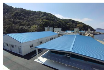
左：種苗生産棟（R4整備） 右：稚魚生産棟（R5整備）
