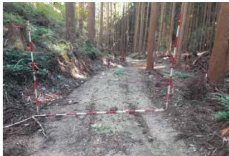
生産基盤整備支援（林内路網の拡幅）
