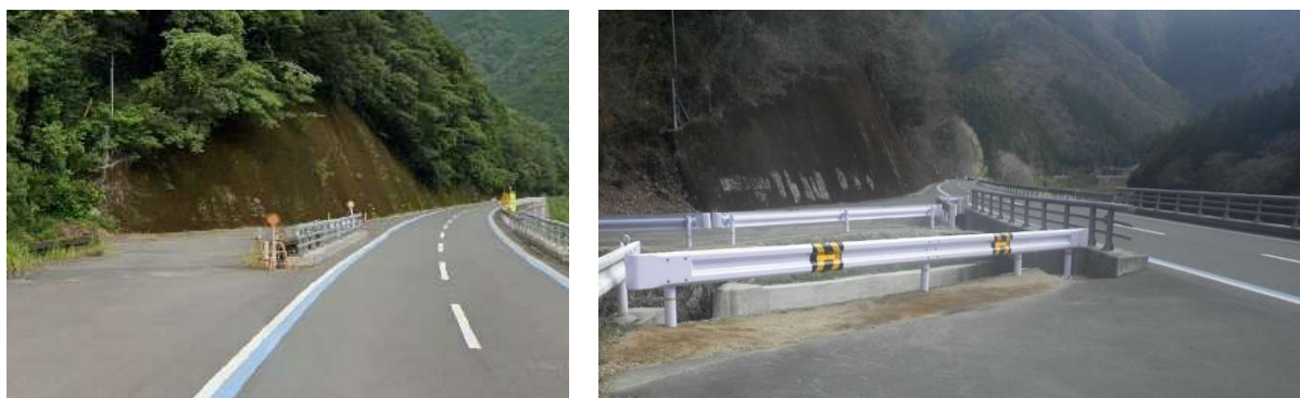
図8 撤去事例（小唐井橋（旧））（左：撤去前、右：撤去後）
