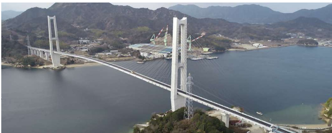
愛媛県が管理する最長の橋梁 岩城橋
