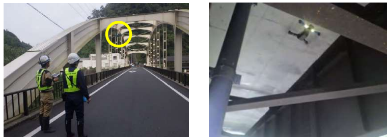
図7 新技術を活用した点検（船戸橋）
