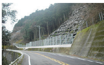
緊急輸送道路の防災対策
