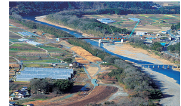
河川改修が進む肱川(大洲市)
