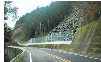
(国) 317号(今治市玉川町) 緊急輸送道路の防災対策
