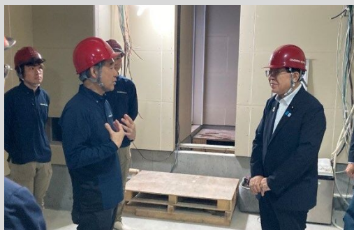
住宅建築の現場
