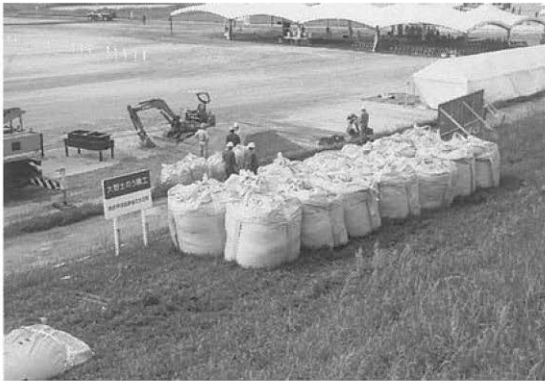
(大型土のう工)
