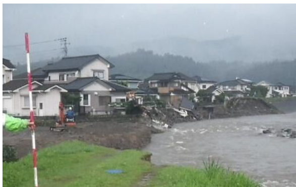
河岸侵食による家屋の倒壊(花月川)
