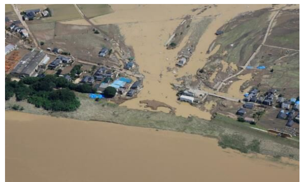
堤防決壊による家屋の流失(鬼怒川)
