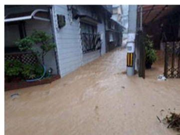
高浜4丁目道路への土砂流入状況
