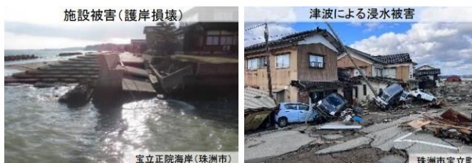
能登半島地震での津波被害
