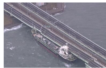
強風に流され関西国際空港連絡橋に衝突したタンカー
