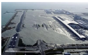
関西国際空港の水没状況
