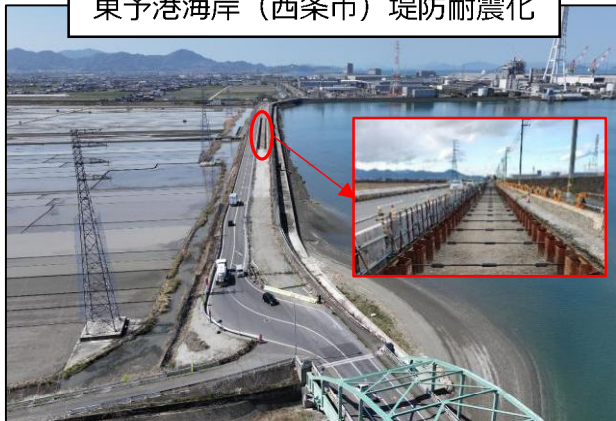
東予港海岸（西条市）堤防耐震化
