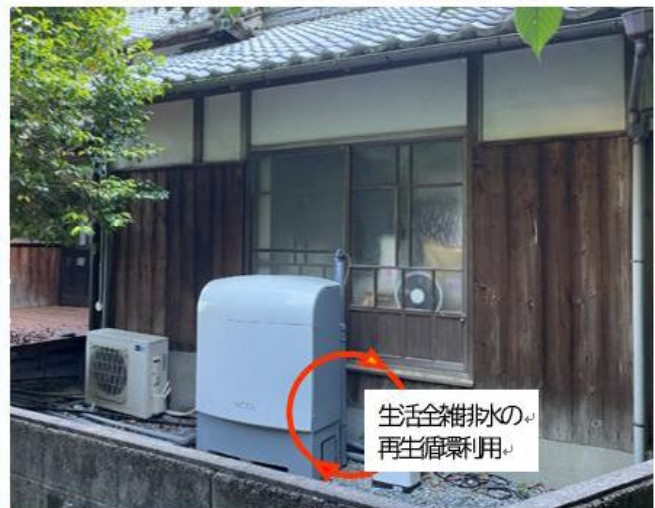
既存住宅の外に設置（配管接続工事）
