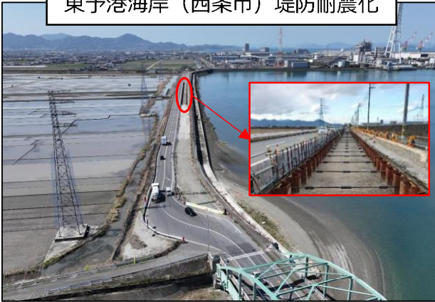
東予港海岸（西条市）堤防耐震化
