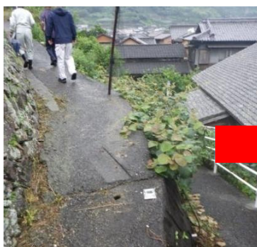
(整備前の避難路)
