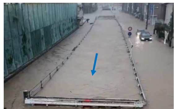
◎県内河川の浸水状況
