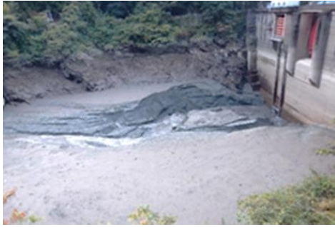
鹿森ダム（新居浜市）堆砂状況
