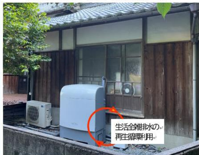
既存住宅の外に設置（配管接続工事）
