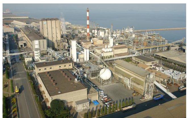
住友金属鉱山（株）がリサイクルプラントを建設する東予工場 （住友金属鉱山のHPより掲載）
