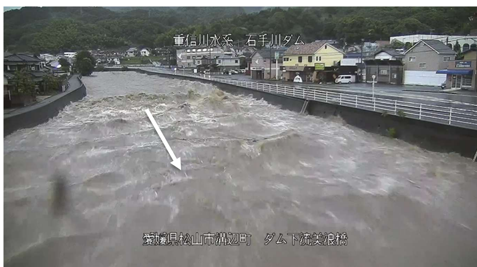
図 3 令和 5 年 7 月洪水被害状況（8.6k 付近 美浪橋地点）
