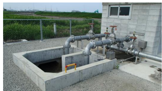
用水のパイプライン化
