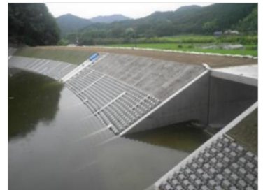
ため池の改修
