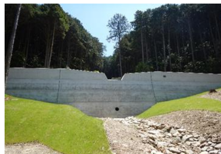
治山施設（谷止工）
