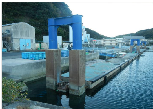
浮体式物揚場の整備
