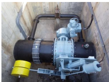
長寿命化対策（管水路の補修）
