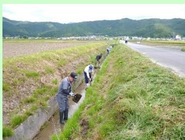
水路の泥上げ
