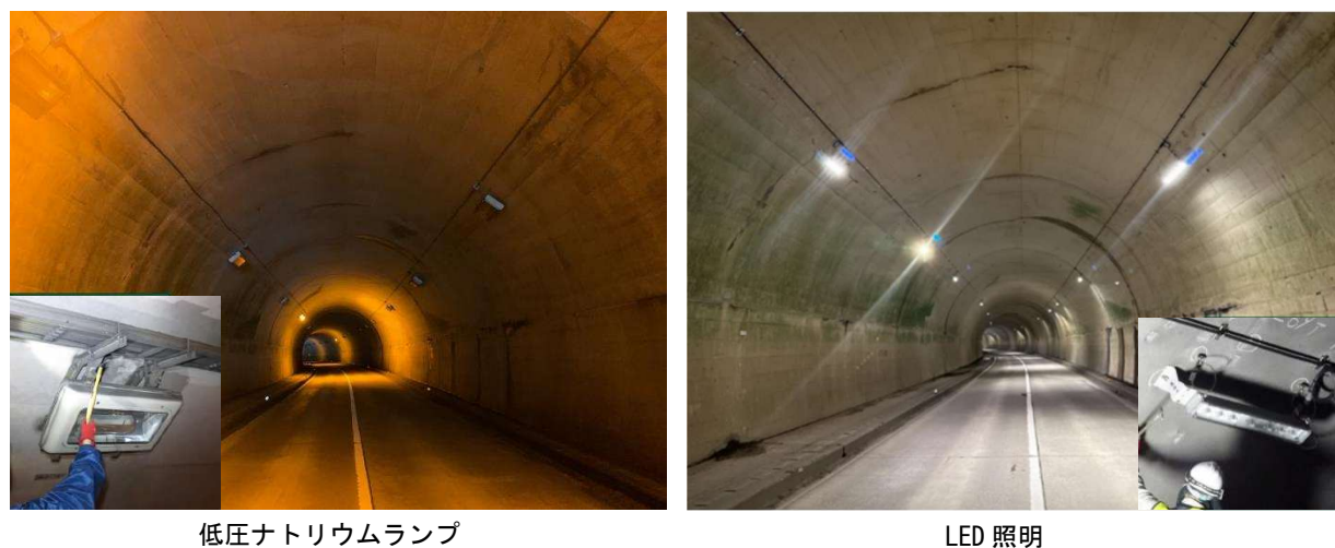
図 8 LED 化後のトンネル照明の比較（下中合トンネル）
