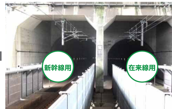
鷺羽山トンネル
