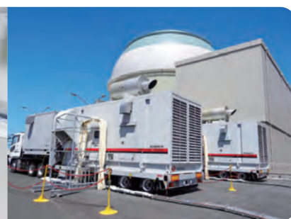
空冷式非常用発電装置
