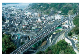
大洲・八幡浜自動車道
