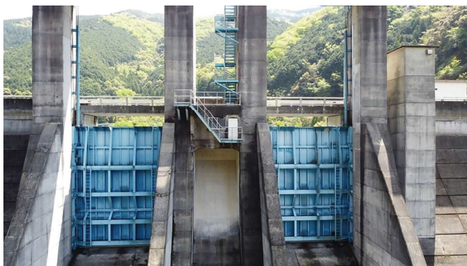
ゲートルーラ改良工事（山財ダム）
