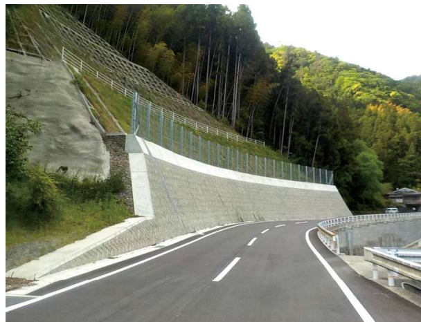
（国）380号 緊急輸送道路の整備
