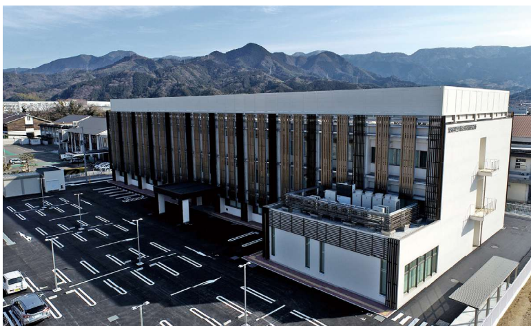
愛媛県衛生環境研究所（外観）
