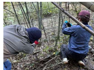
獣害対策のための防護柵設置
