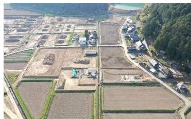
ほ場整備施工状況（伊延西）
