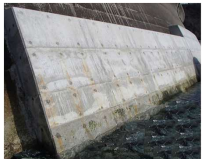
護岸補修状況
