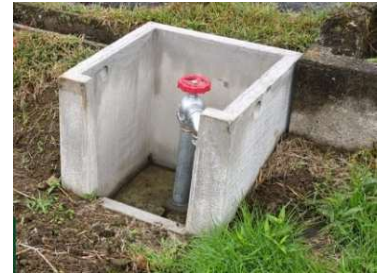
[図11] 用水路のパイプライン化 給水栓施工状況（ナベラ地区）
