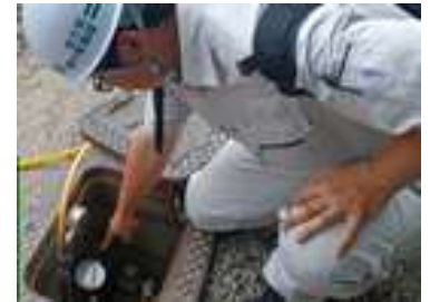
[図12] 用水路のパイプライン 加圧試験状況（永子地区）
