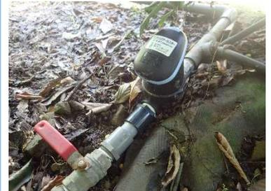
【図7】設置した電磁弁
