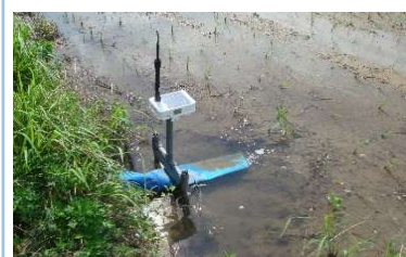
[図9] 自動開閉式給水ゲート
