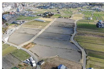
【図27】水田ほ場整備の施工状況（南吉井地区）
