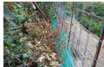
【図23】モデル集落で補強を実施した侵入防止柵
