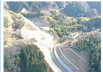
農道整備 （歌仙3期地区）
