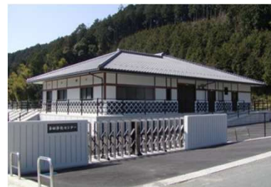
農業集落排水施設
