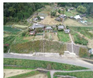
地すべり対策（法枠）
