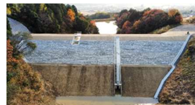
ため池の改修
