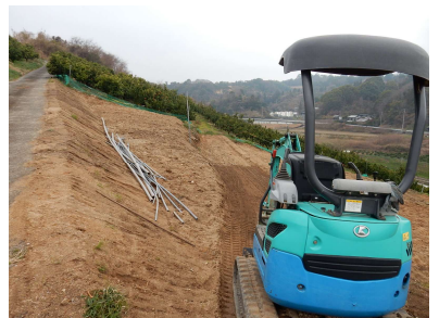
農家自主施工による緩傾斜化
